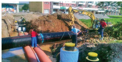
Pokládka teplovodu pod hladinu potoka
