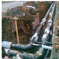
Pokládka teplovodu
